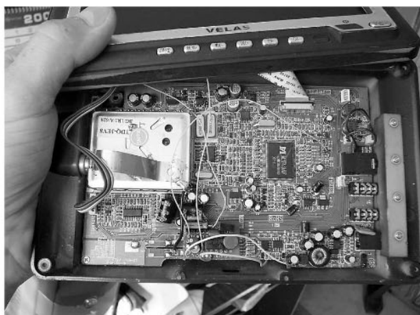
Рис. 2.9.6. Монтаж DC/DC-преобразователя в корпусе телевизора
